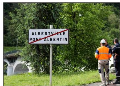
Le pont Albertin a été construit entre 1862 et 1866 et a subi des travaux en 1998 et 1999. Photo Le DUS/M.
