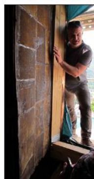
Benoît Chambre est en charge des travaux de rénovation (avec Dominique Perron, architecte du patrimoine). Il a expliqué les différentes étapes de la rénovation du clocher. L'occasion d'approcher au plus près des quatre cloches qui datent du milieu du 19 e siècle. Photo LD/LGA.
