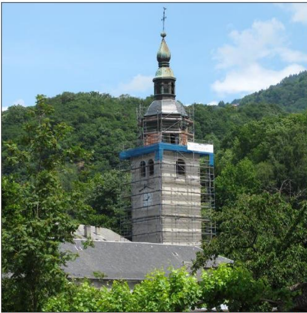
Commencés en février avec quelques mois de retard, les travaux de restauration de la couverture du clocher et de son accès devraient être terminés à la fin de l'été. Dans la foulée, le chantier de rénovation des trois chapelles latérales de l'église va débuter. Photo LD/LGA.
